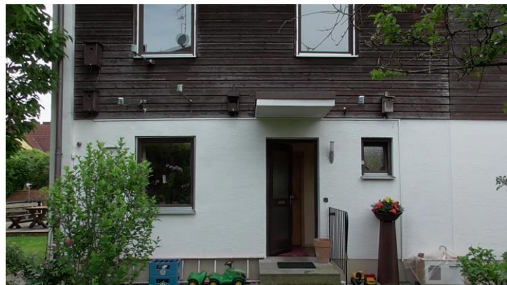
Bild 2a: Die Nistkästen NK01, NK03, NK04, NK05 (von rechts) an der Nordseite des Hauses
